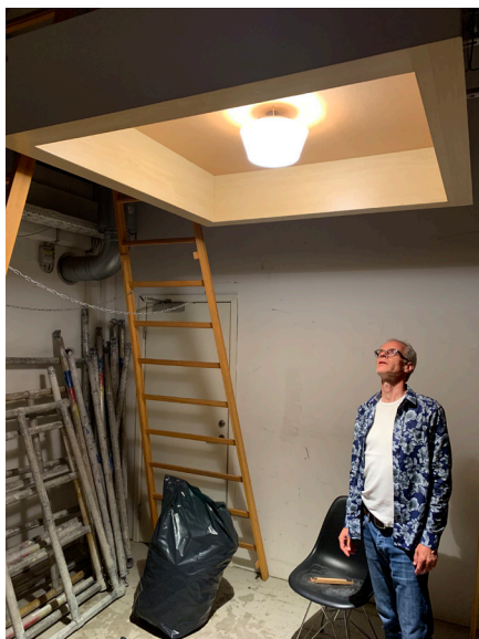
Mock-up af en enkelt loftkassette udført i pap og træ-tapet. Armaturet oplyser både kassetten selv og gulvet nedenunder, som to uafhængigt styrede funktioner.
