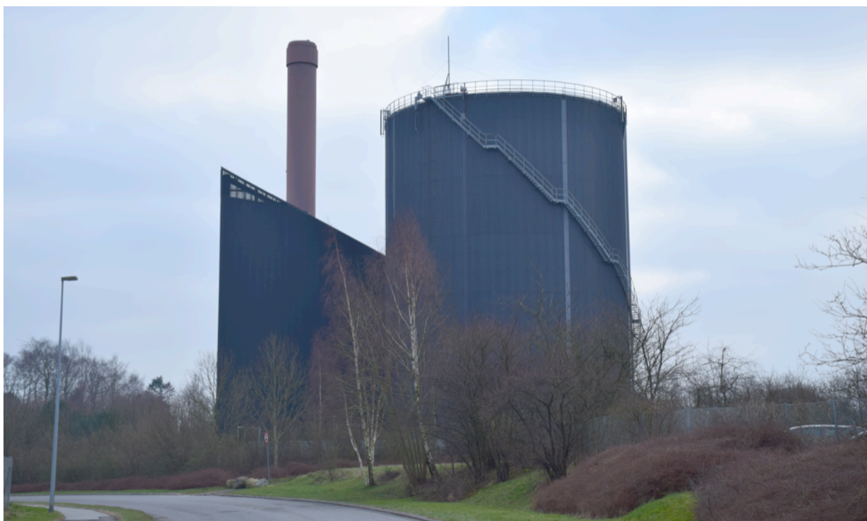
Helsingør Kraftvarmeværk skal fornyes og ombygges frem til 2018.
